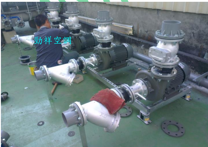
水泵安裝(管路配件裝置)
