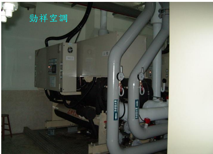
東元水冷滿液螺旋式冰水主機
