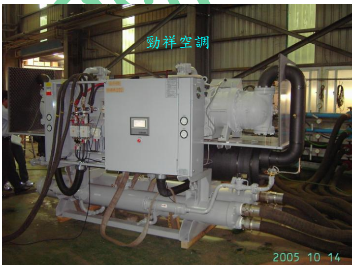
弘旭水冷滿液螺旋式冰水主機
