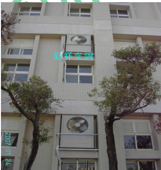
氣冷分離式室外機(外牆施工)
