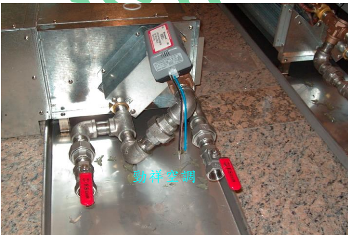
吊隱式冰水室內送風機+三通閥
