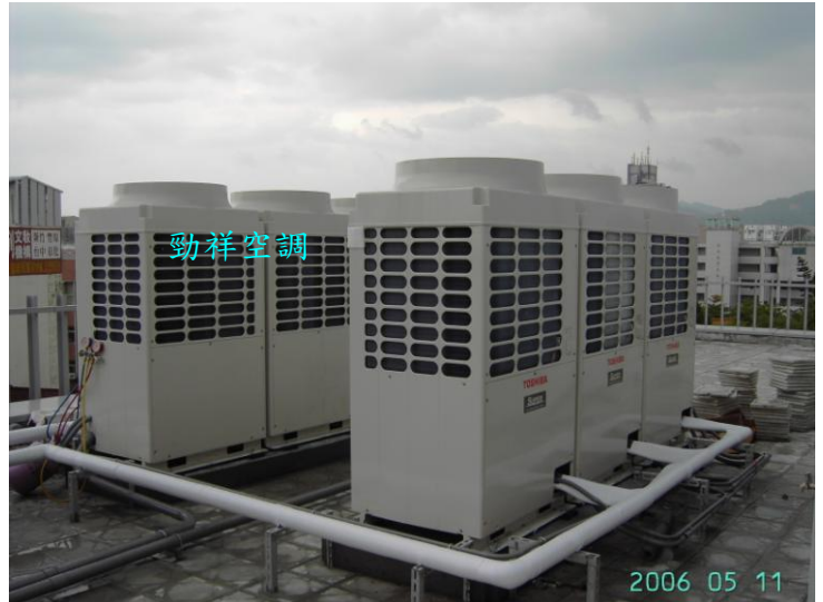
VRF 室外機組合(外牆施工)
