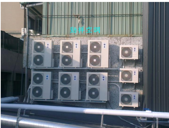
氣冷分離式室外機(外牆施工)
