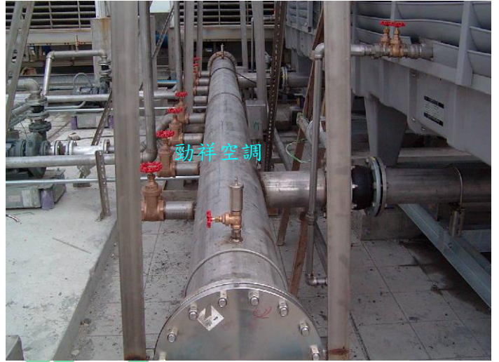
冷卻水管集水頭(不銹鋼管)
