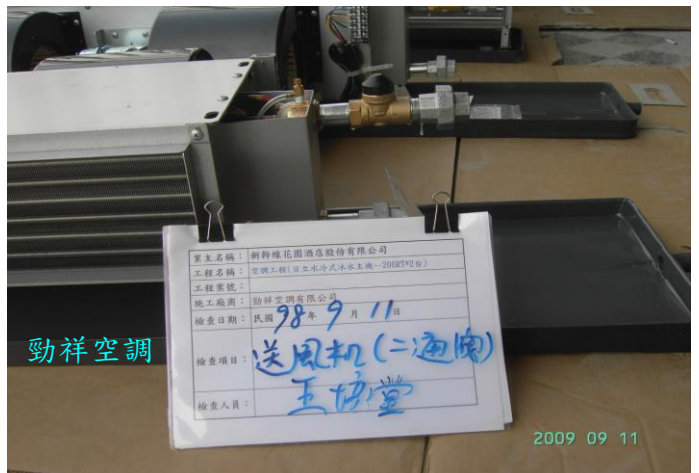
吊隱式冰水室內送風機+二通閥
