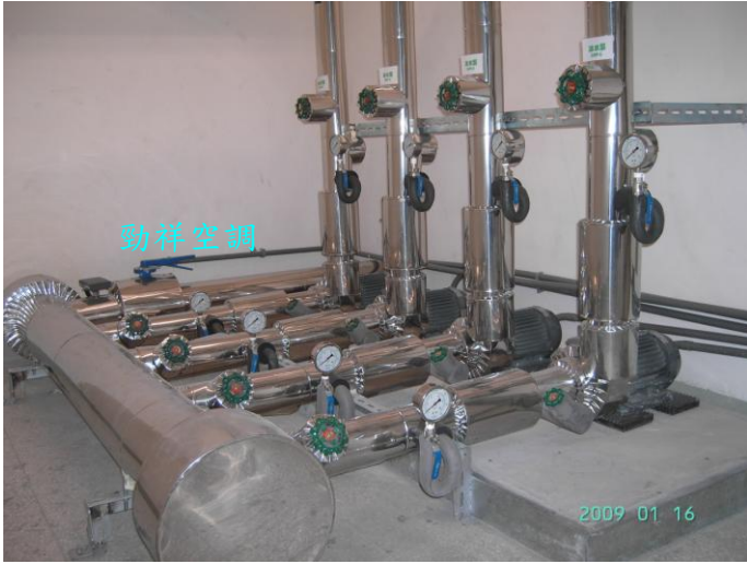
冰水泵+PE 保溫外加鋁皮
