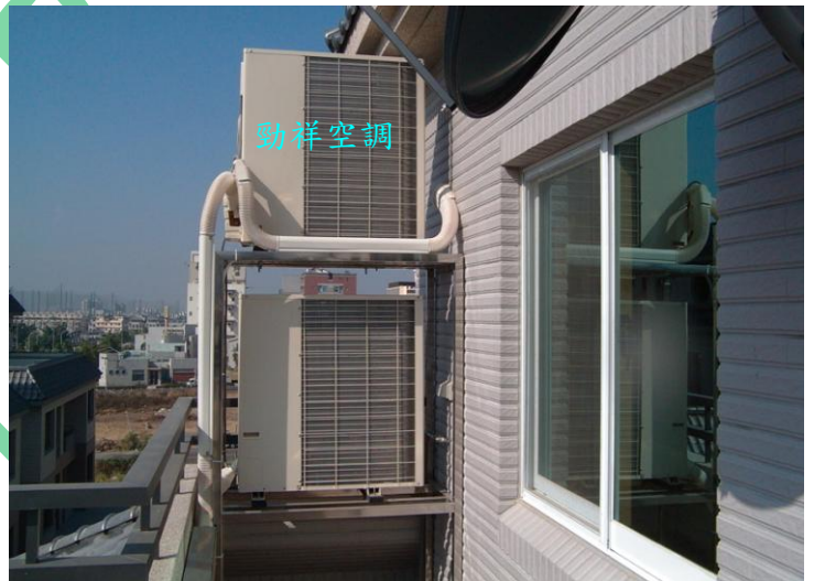
氣冷分離式室外機(不銹鋼安裝架施工)
