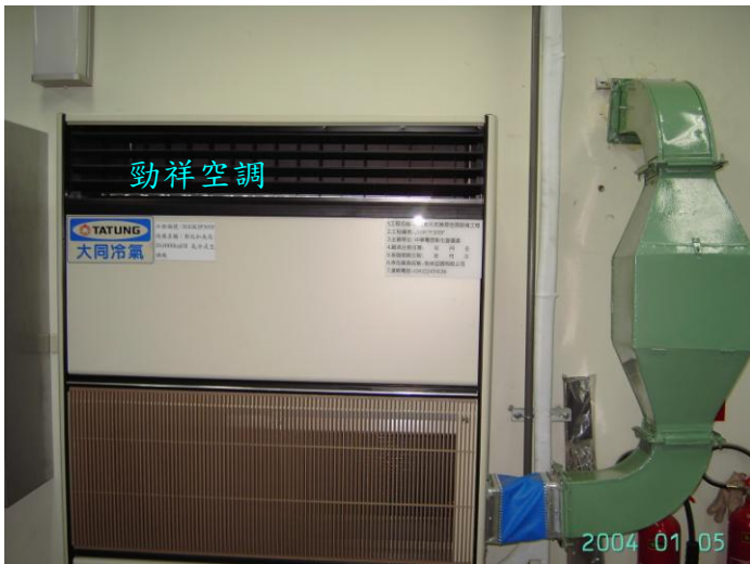
氣冷箱型機+外氣風管
